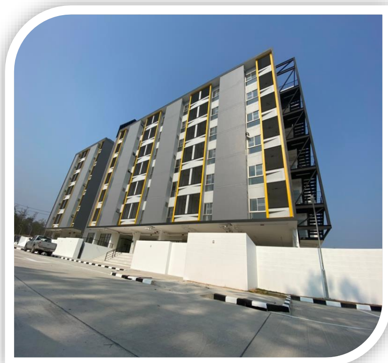
โครงการก่อสร้างอาคารหอพักนักศึกษา พื้นที่ศูนย์แมริม หลังที่ 2
