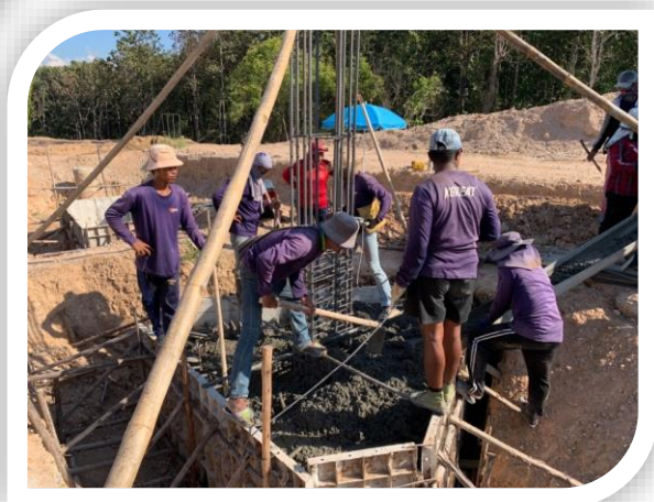
โครงการจ้างก่อสร้างอาคารวิศวกรรมและก่อสร้าง
